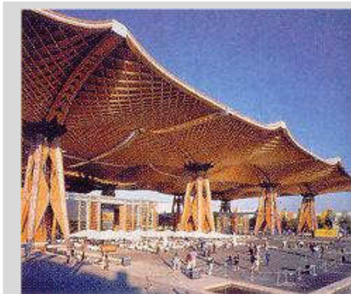
Structure allemande faite uniquement de bois Cadwork / Québec-Science
